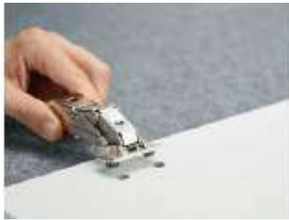
2. Вставляємо дюбелі в просвердлені отвори
